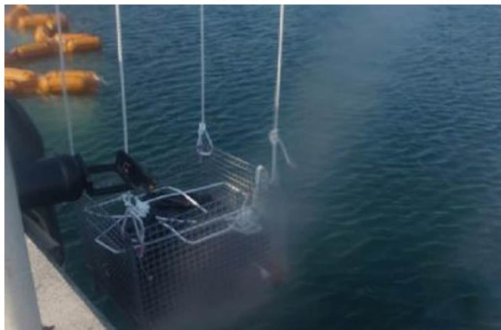
In Sandsäcken wird Zeolith ins Meer bei Reaktor Nr. 3 von Fukushima Eins versenkt. (Foto: Tepco) Foto: dpa
